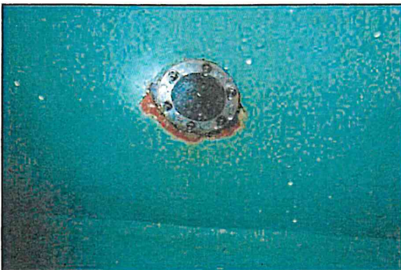
Abbildung 3.8-10: Korrosionsschäden an Anbauteilen (hier: alte Lüftungsdurchführung in der Decke)
