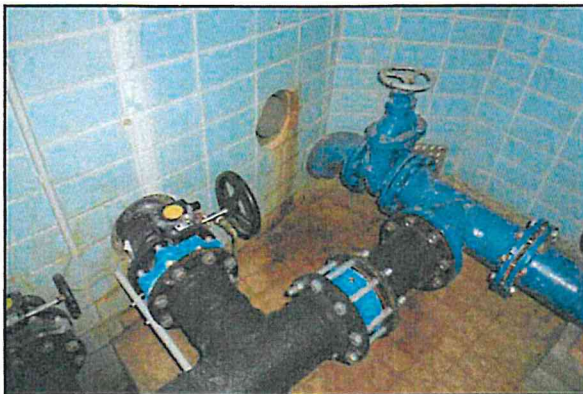
Abbildung 3.3-5: Korrosion an Einbauelementen / Wanddurchführungen
