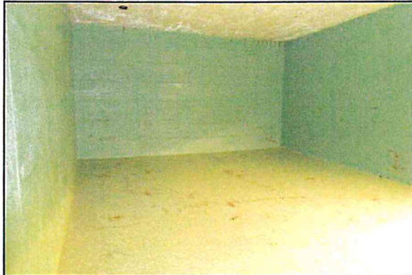
Abbildung 3.4-7: Ansicht der Wasserkammer mit einer großen Anzahl von Korrosionsstellen
