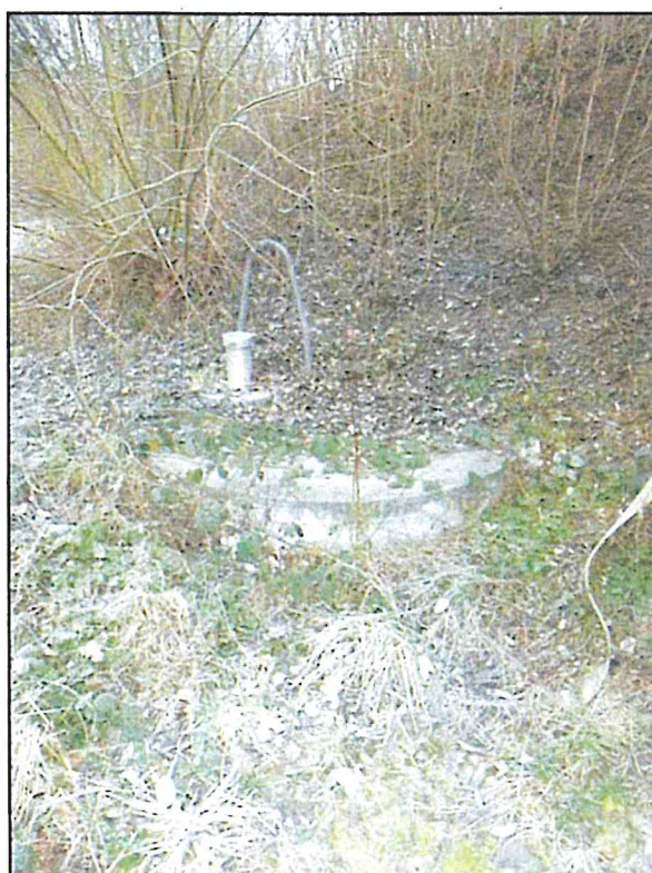
Abbildung 3.2-2: Bewuchs über / auf der Wasserkammer und dem Anschlusschacht
