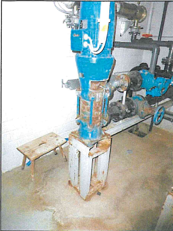
Abbildung 3.2-6 & 7: Korrosion an hydraulischen Einrichtungen
