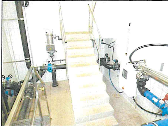
Abbildung 3.1-4: Geflieste Stahlbetontreppe vom UG zum EG des Bedienungshauses Optisch sind keine Mängel festzustellen.
