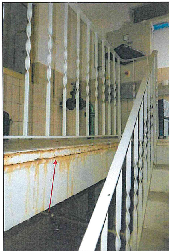
Abbildung 3.4-2 & 3: Defekte Abschlussleiste (Korrosion) in der Decke zwischen EG und UG
