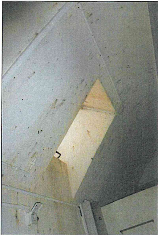
Abbildung 3.9-5: Starke Verunreinigungen am Einstieg in den Quellsammelschacht
