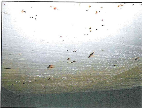
Abbildung 3.4-10: Korrosionsschäden an der Decke
