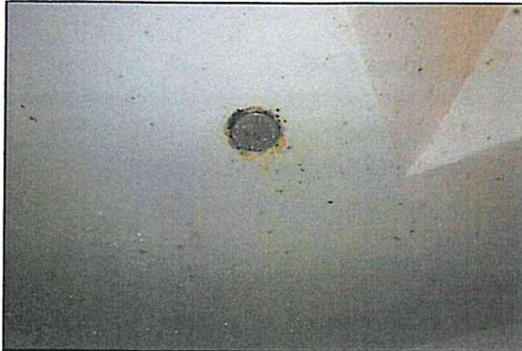
Abbildung 3.6-5: Korrodierte Einbauteile in der Decke des Quellsammelschachtes
