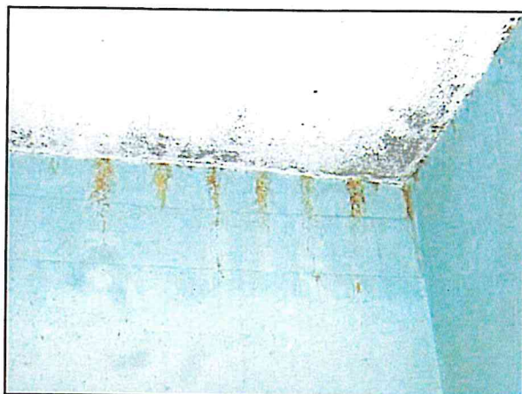
Abbildung 3.4-11: Korrosionsschäden am Übergang Wand-Decke
