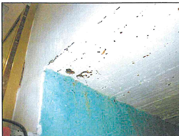
Abbildung 3.4-9: Erhebliche Korrosionsschäden an der Decke der Wasserkammer
