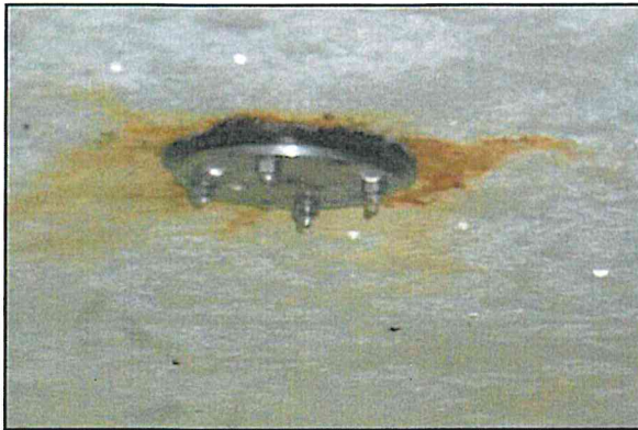
Abbildung 3.11-6: Korrosion an der Decke im Bereich der Einbauteile
