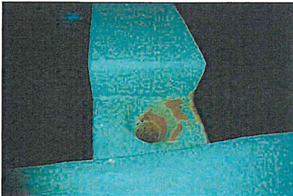
Abbildung 3.9-8: Schäden an der Betonoberfläche bzw. der Beschichtung
