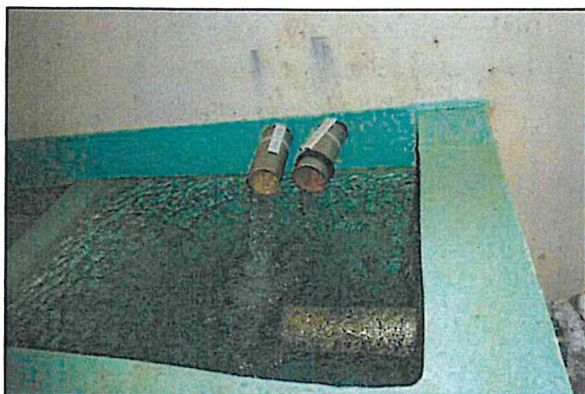
Abbildung 3.6-6: Stark verunreinigte Wandoberfläche oberhalb des Quellsammelschachtes korrodierte Rohrdurchführungen
