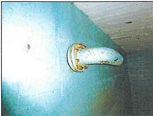
Abbildung 3.4-8: Starke Korrosionsschäden an Einbauteilen in der Wasserkammer
