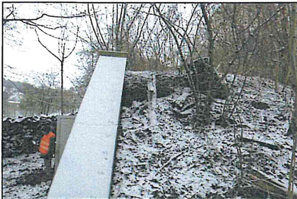
Abbildung 3.11-2: Keine Absturzsicherung montiert, Unfallverhütungsvorschriften (UVV) nicht eingehalten
