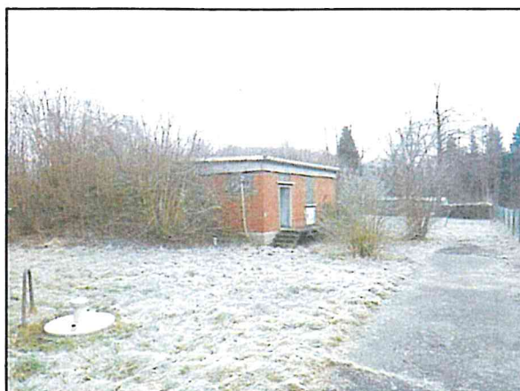
Abbildung 3.2-1: Ansicht des Bedienungshauses - starker Bewuchs über / auf der Wasserkammer
