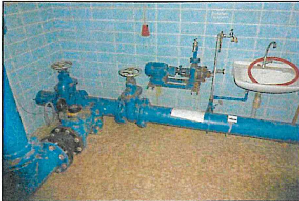
Abbildung 3.3-4: Korrosion der hydraulischen Einrichtungen
