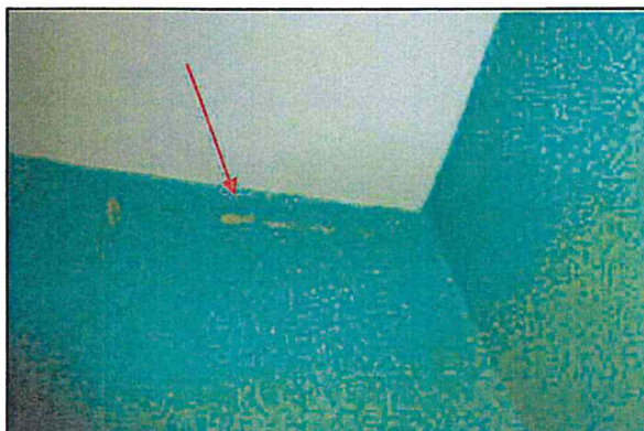
Abbildung 3.8-14: Weiterer Riss im Wand-Decke-Bereich
