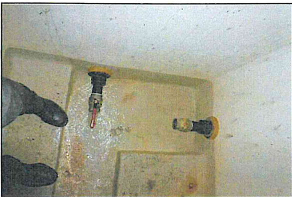
Abbildung 3.6-8: Korrodierte Einbauteile im Grundablass
