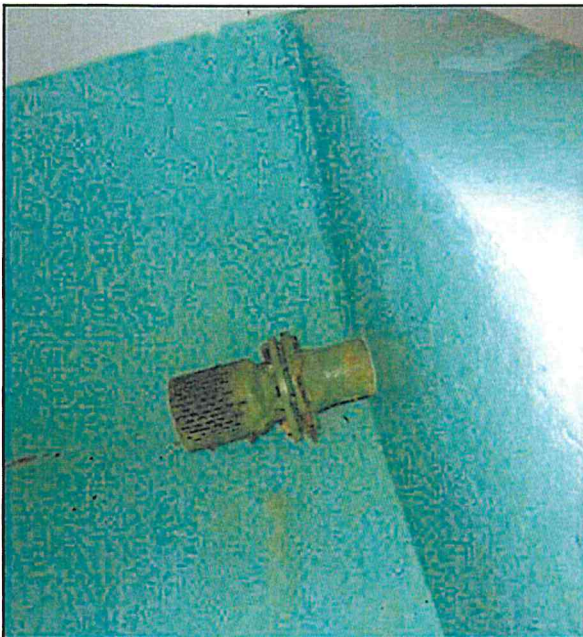
Abbildung 3.11-4: Korrodierte Einbauteile im Quellsammelschacht
