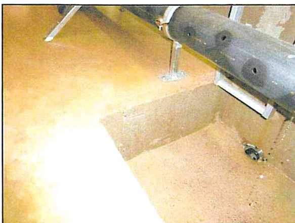
Abbildung 3.1-6: Pumpensumpf in der Wasserkammer (rechts 750m³)
