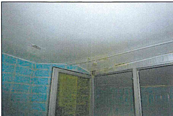
Abbildung 3.3-3: Schäden an der Beschichtung der Decke des Bedienungshauses
