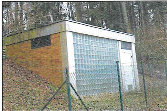
Abbildung 3.4-1: Ansicht des Bedienungshauses – Glasbaustein- wand führt zu unerwünschtem Lichteinfall
