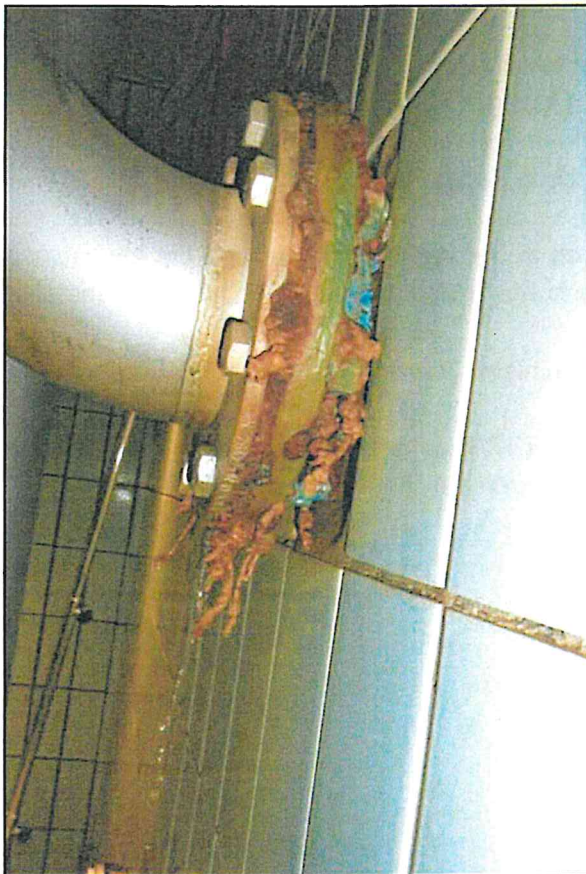
Abbildung 3.12-9 & 10: Stark korrodierte Wandeinbauteile in der Wasserkammer
