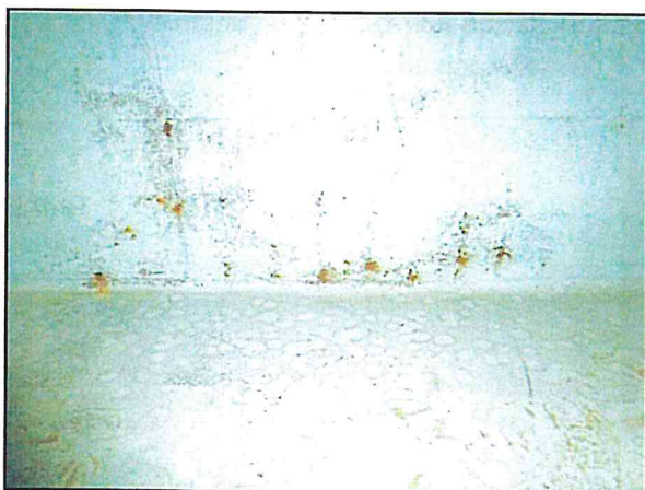
Abbildung 3.4-12: Korrosionsschäden am Übergang Wand-Boden
